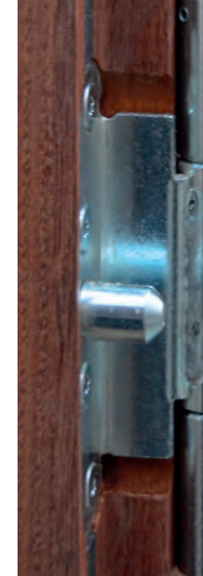
DETAIL TRNŮ PROTI VYSAZENÍ
