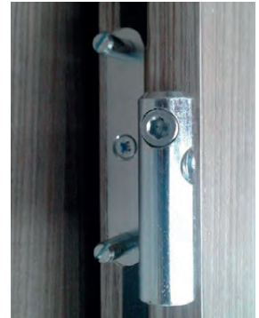
DETAIL TRNŮ PROTI VYSAZENÍ
